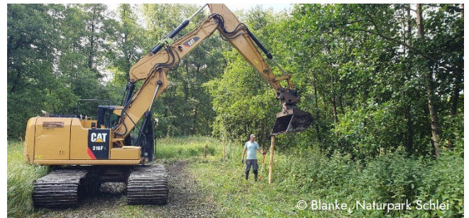
Abb. 12: Die Pfähle für die Einzäunung werden auf dem Flurstück an der Waldmühle in Schleswig gedrückt.
